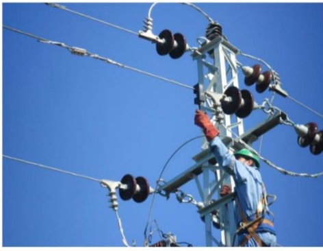
فنى الكهرباء التابع للشركة اثناء تركيب المبین
